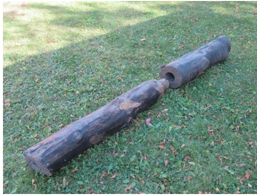
Voici un exemple de conduite en bois découvert dans l'actuel chantier de la rue du Manoir à Montmagny.
