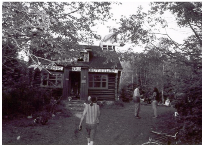
POUR PROTÉGER CONTRE LA DÉMOLITION DES PETITES MAISONS D'YVON GUINDON, DES GENS SE SONT ENCHAÎNÉS AUX ARBRES ET ONT OFFERT UNE RÉSISTANCE PASSIVE PENDANT DES SEMAINES À L'ÉTÉ 2003. C'EST SUR CES TERRAINS QUE LE CHALET D'ACCUEIL ANNE-PICHÉ EST AUJOURD'HUI INSTALLÉ. SOURCE: JOURNAL SKI-SE-DIT
